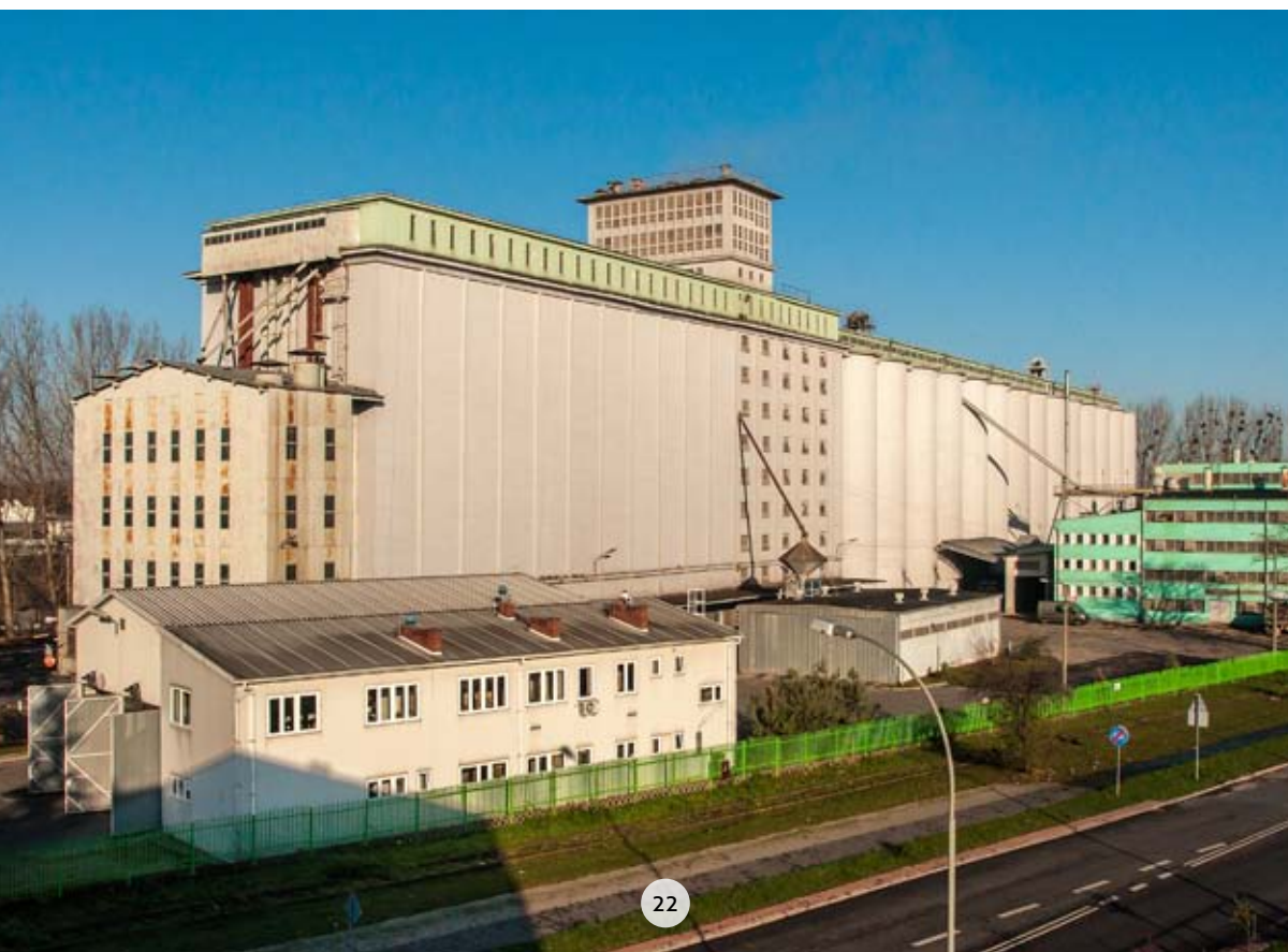
Zamojskie Zakłady Zbożowe / Corn Processing Plant in Zamość
