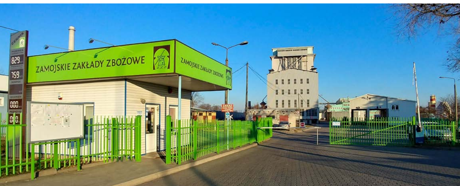
Zamojskie Zakłady Zbożowe (fot. archiwum Zamojskie Zakłady Zbożowe) / Grain plant in Zamość (photo from Grain plant archives)
