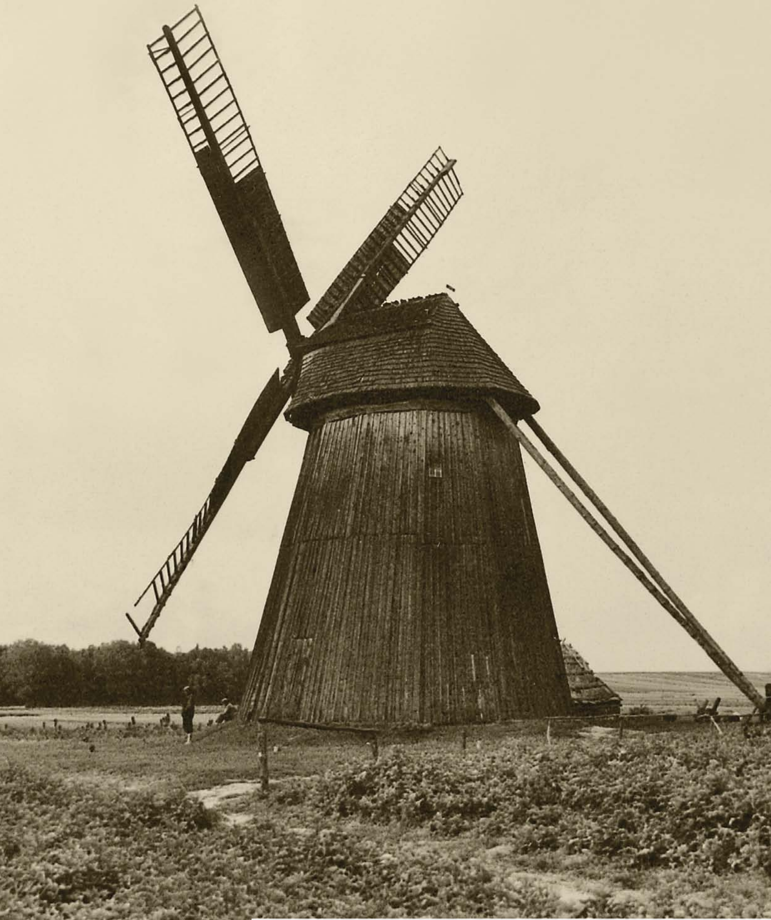
Wiatrak w Klemensowie przed 1939 r. (Wojewódzki Urząd Ochrony Zabytków w Lublinie Delegatura w Zamościu) Windmill in Klemensów before 1939 (WOUOZ DZ)
